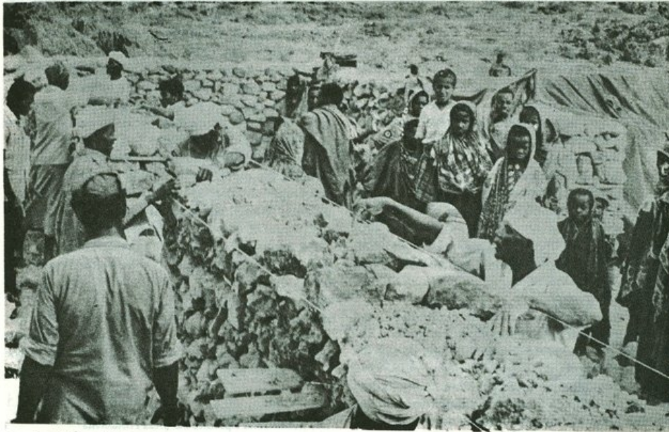
Bau eines Gesundheitszentrums.
