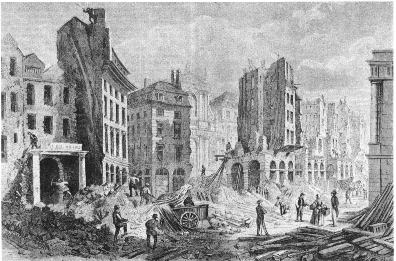
Demolition in Paris: Straßendurchbrüche für den Boulevard du Palais
