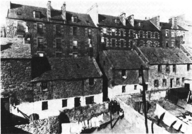
Dundee, Cottages, dahinter Wohnhäuser jüngeren Datums
